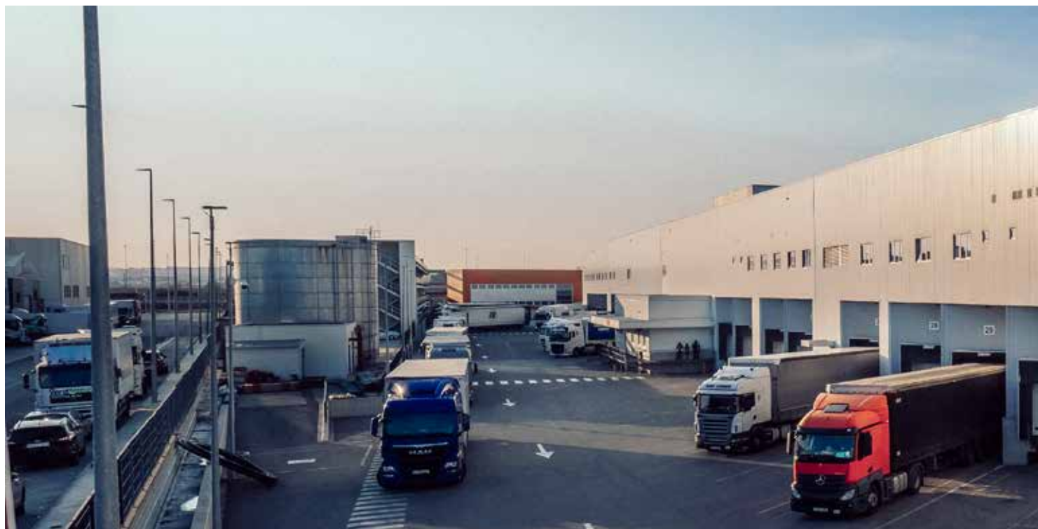
Muelles de la plataforma logística de Silla (Valencia)
